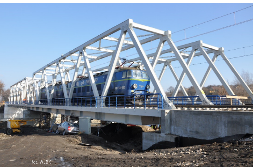
Badania mostu kolejowego przez Wisłok w Rzeszowie.
