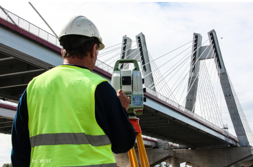
Badania mostu drogowego przez Wisłę w Krakowie.
