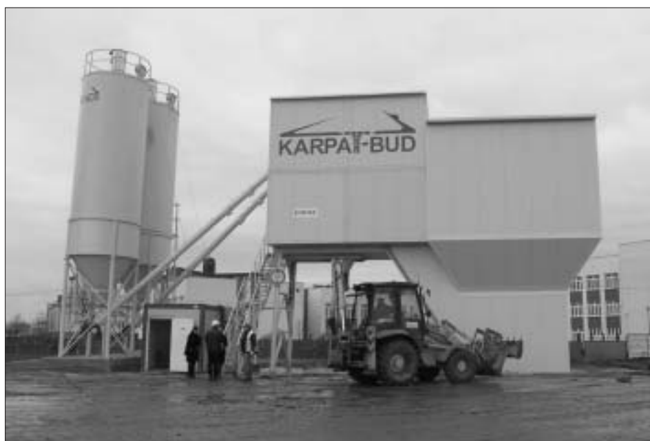
Betonownia na placu budowy.
