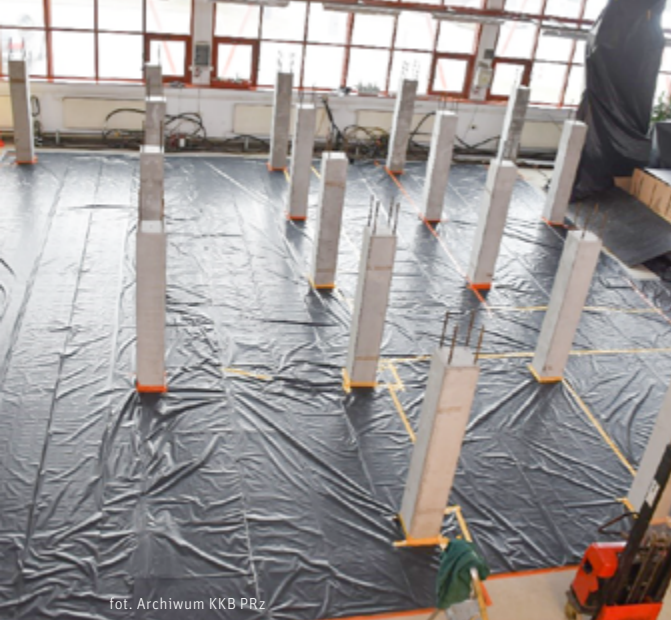
↑ Fot. 2. Montaż słupów prefabrykowanych.
