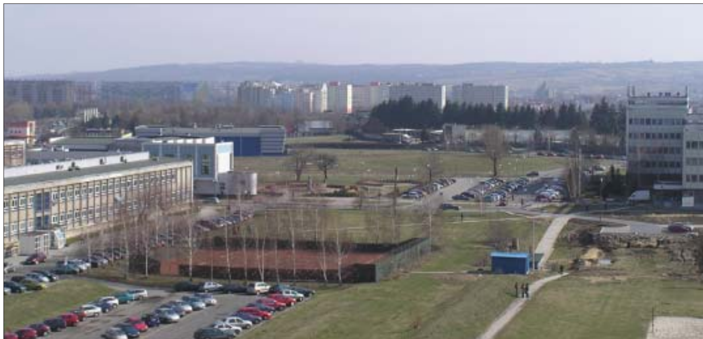
W tym miejscu staną nowe obiekty.
