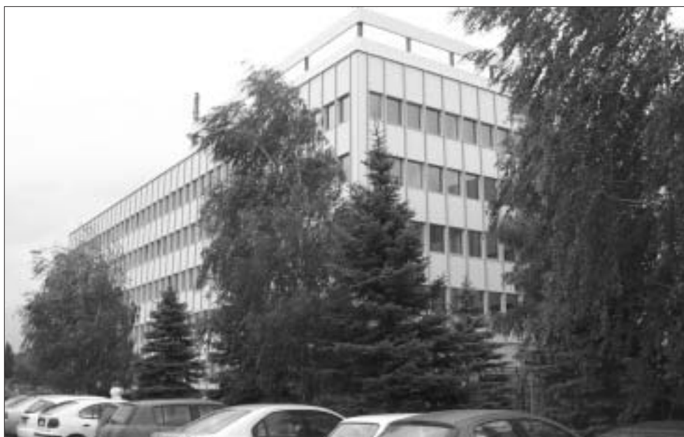
Budynek L w nowej szacie.
