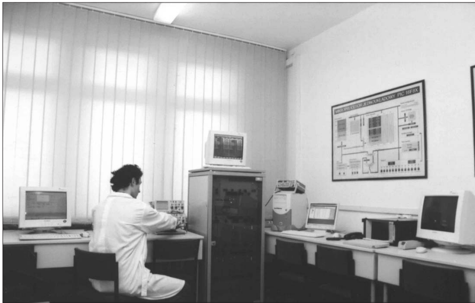
Stanowisko dydaktyczne cyfrowej centrali telefonicznej DGT 3450 w laboratorium systemów telekomunikacyjnych (Zakład Systemów Elektronicznych i Telekomunikacyjnych).
