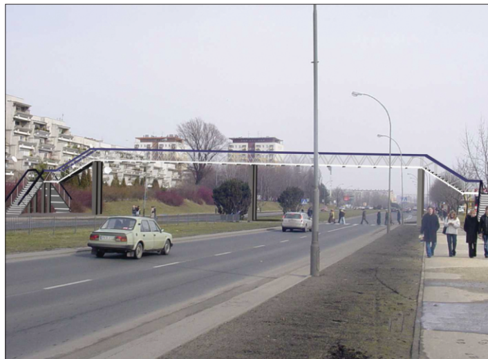
Kładka dla pieszych z aluminium nad al. Powstańców Warszawy.
