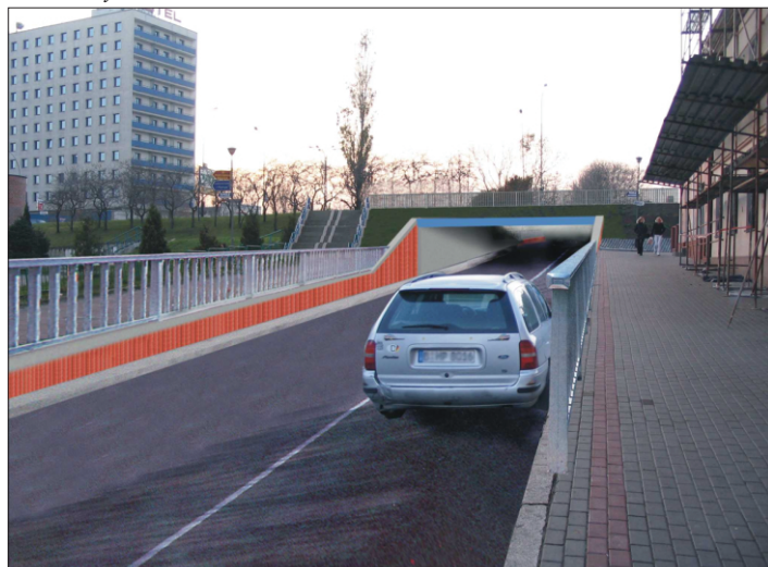
Tunel w ciągu ul. Jabłońskiego w Rzeszowie.
