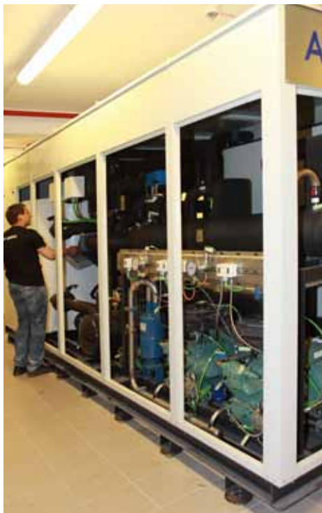
Praca przy agregacie chłodniczym komory klimatycznej do badania emisji spalin.
