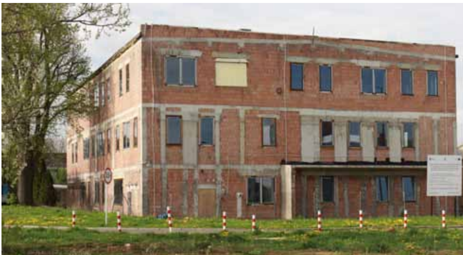
Zespół Laboratoriów dla Wydziału Budownictwa i Inżynierii Środowiska w budowie.
