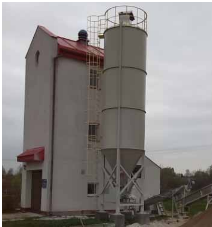
Nowoczesna instalacja przetwarzania osadów ściekowych w oczyszczalni w Głogowie Małopolskim
