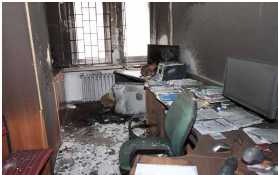
Pomieszczenie po pożarze.
