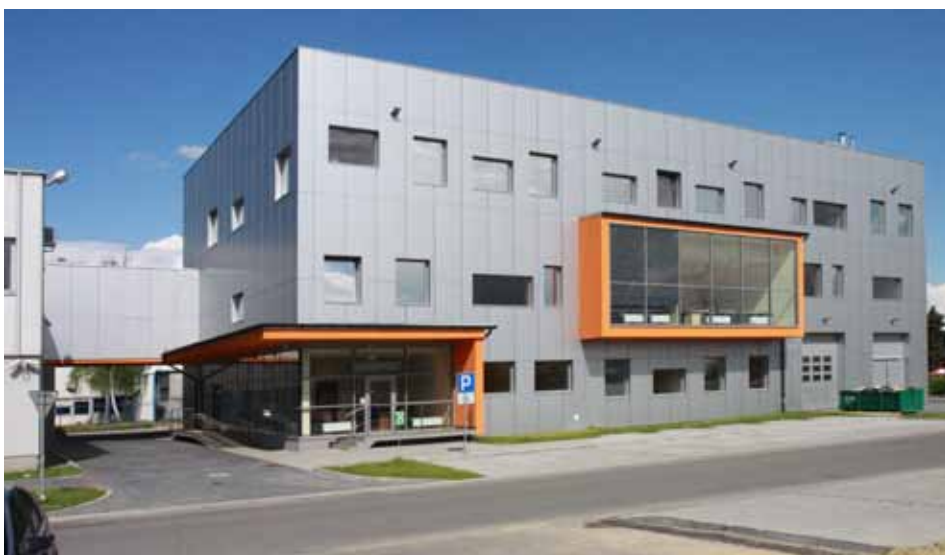
Budynek Zespołu Laboratoriów dla Wydziału Budowy Maszyn i Lotnictwa.
