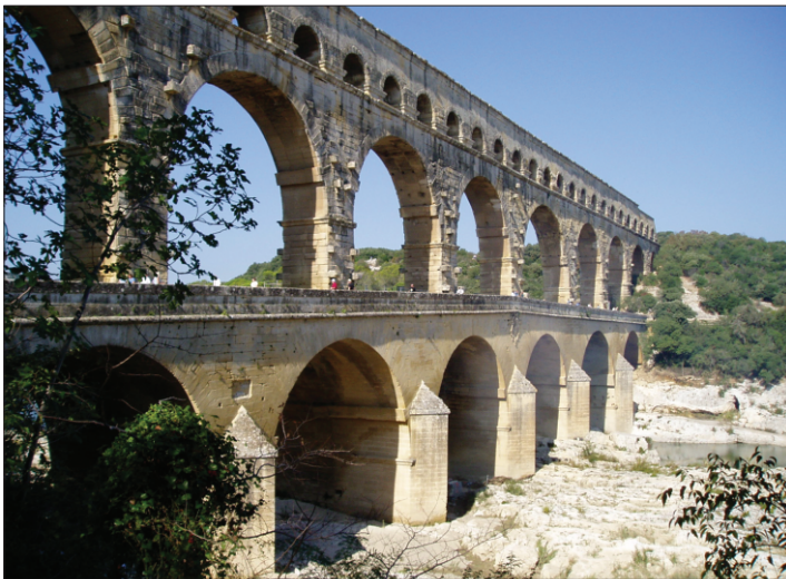
Akwedukt rzymski Pont du Gard z I w. naszej ery.
