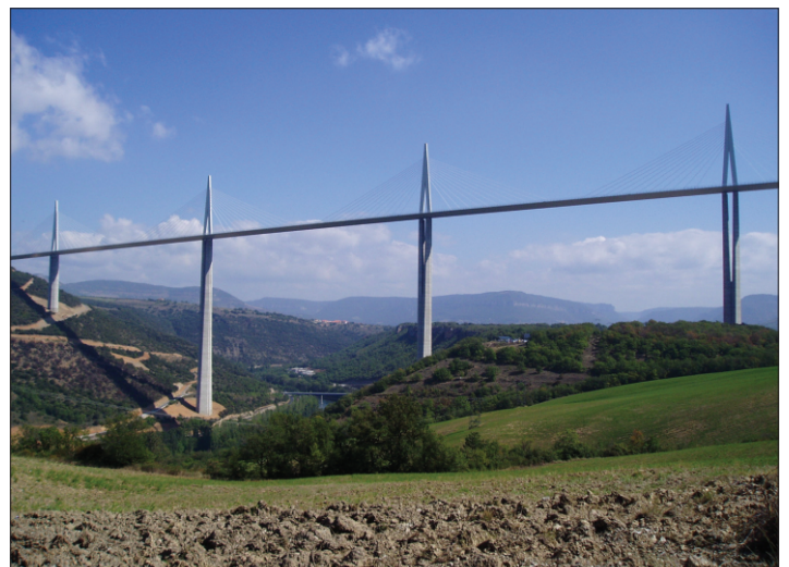
Wiadukt Millau - najwyższy obiekt mostowy na świecie.
