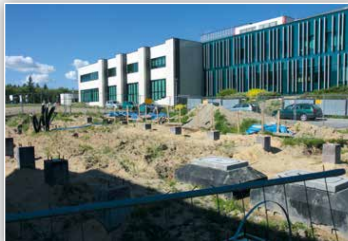
Budowa Uczelnianego Centrum Przetwarzania Danych.
