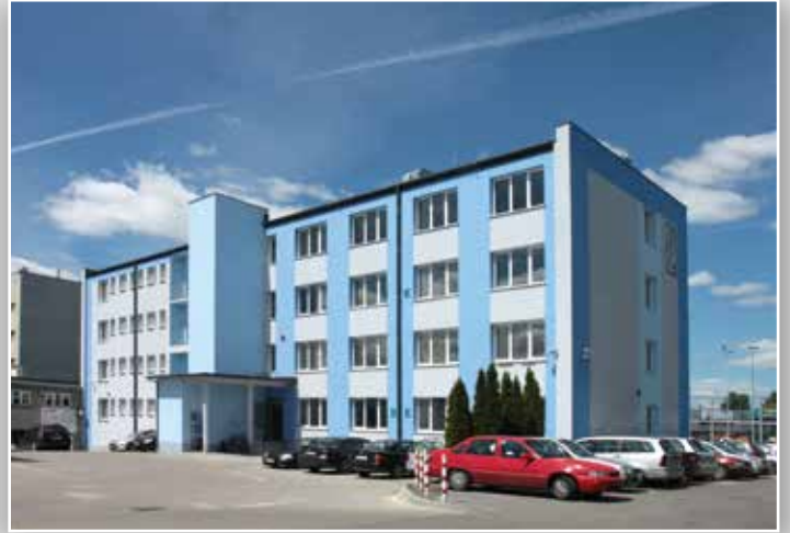
Rozbudowa budynku J przy ul. Podkarpackiej.
