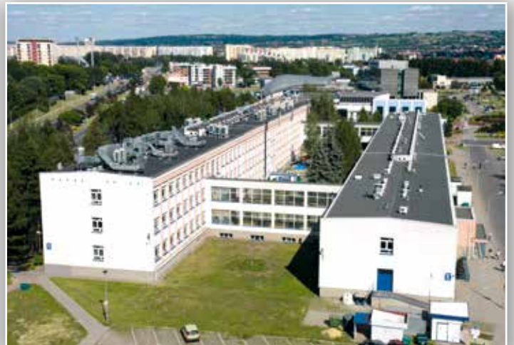
Z lewej: przebudowa wentylacji na Wydziale Chemicznym.
